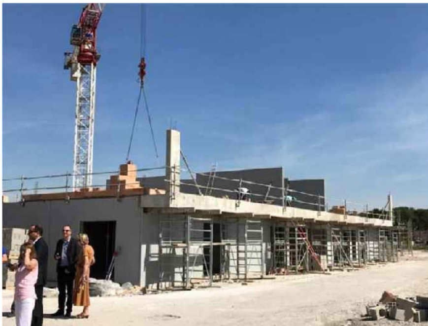
Le chantier est déjà bien avancé, mais la première pierre symbolique n'a été posée qu'hier. A.P.
