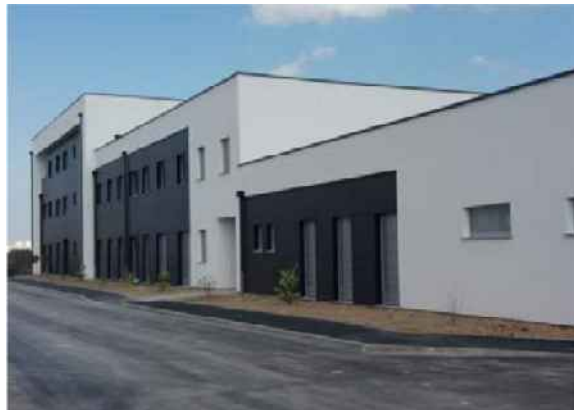
Bureau Veritas France a fait construire un bâtiment de 1 300 mètres carrés à Bezannes, à la périphérie de Reims.
