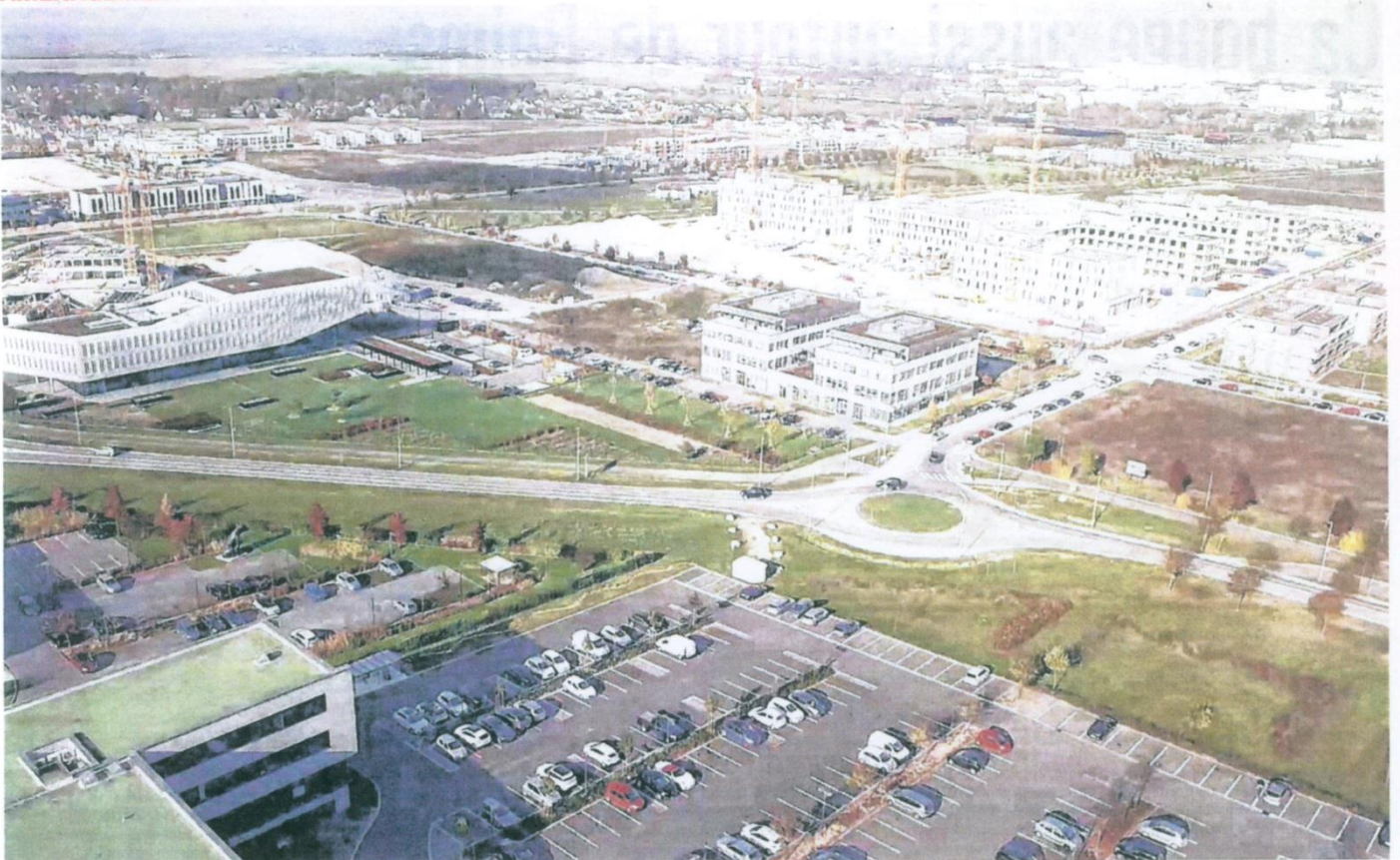
Au plus fort des travaux sur l'ensemble de Bezannes on dénombrait plus d'une quinzaine de grues et quelques centaines d'employés. Ville de Bezannes
