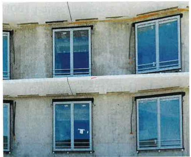
Des casquettes de béton créent des faux balcons aux ponts thermiques limités.
