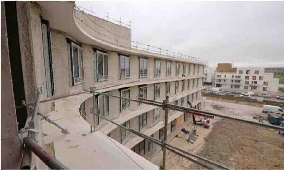
D'une chambre de la future maternité, on voit bien la forme arrondie des ailes du bâtiment qui oblige les entreprises à réaliser des poutres architecturales. Photos Remi Wafflard
