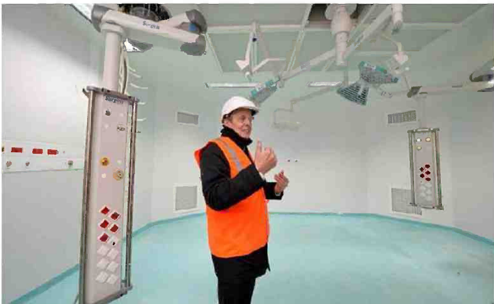
Yves Noël, directeur général adjoint du groupe Courlancy, dans un futur bloc opératoire. Toute la technique est placée dans le plafond.
