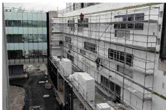
Les équipes ont entamé les travaux d'isolation extérieure. © L'Hebdo du Vendredi
