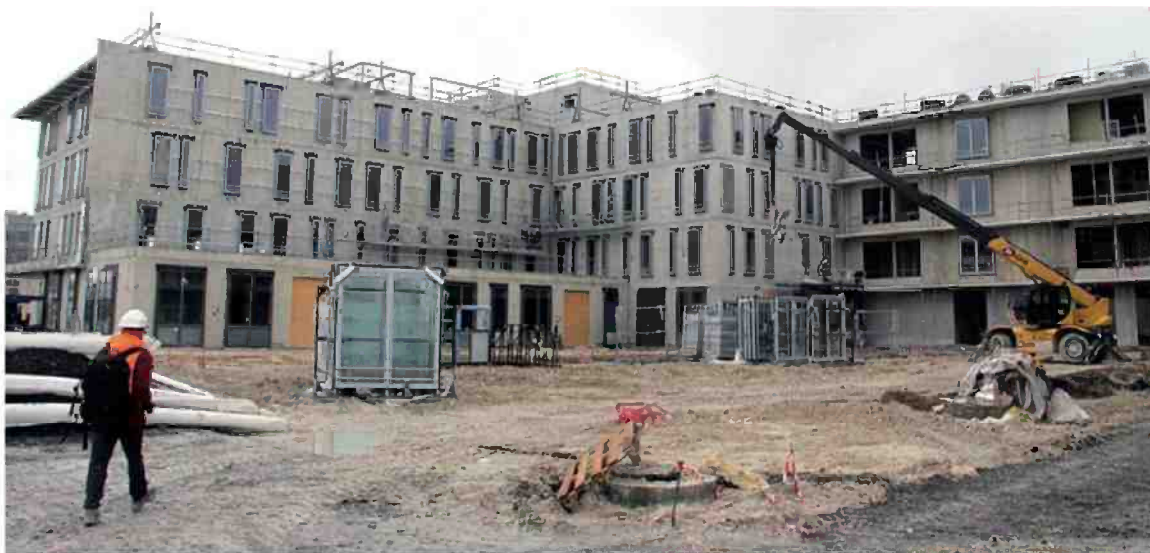
La pose des fenêtres et cloisons est achevée à 50 %. © L'Hebdo du Vendredi
