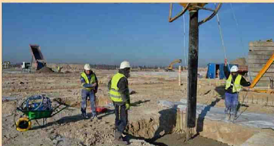
Environ 80 % des lots de sous-traitance n'ont pas encore été attribués sur le chantier de Reims-Bezannes. Hervé Durbin
