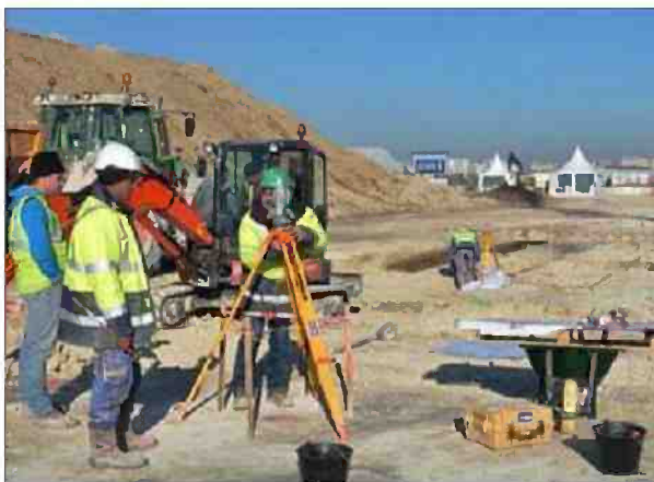
Il y aura jusqu'à 500 personnes travaillant en même temps sur ce gigantesque chantier qui va durer plus de deux ans.
